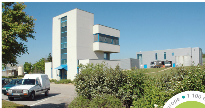
Station d'épuration de Traffeyères.
